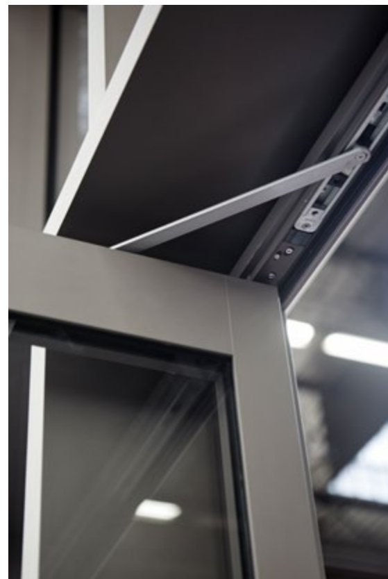
Cierra-puertas encastrado en el travesaño superior
