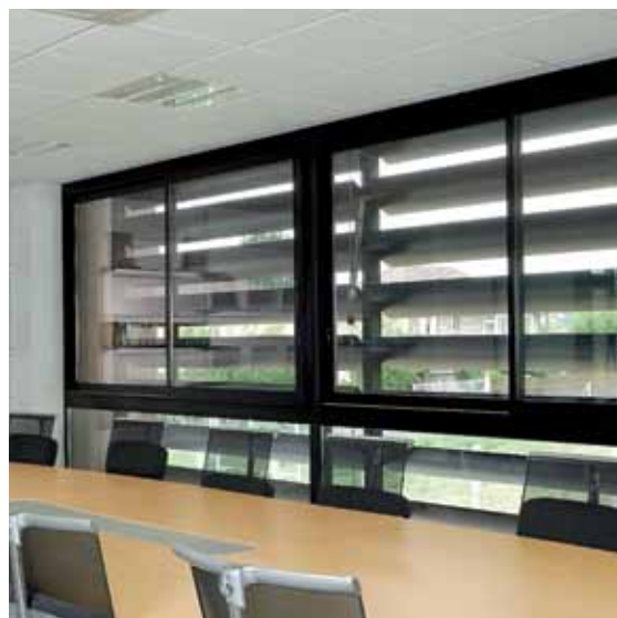
Arquitectos: J-P. Dhalluin y P. Peny - Fotógrafo: Patrick Loubet Lamas de 300 mm motorizadas - Inclinación 45°
