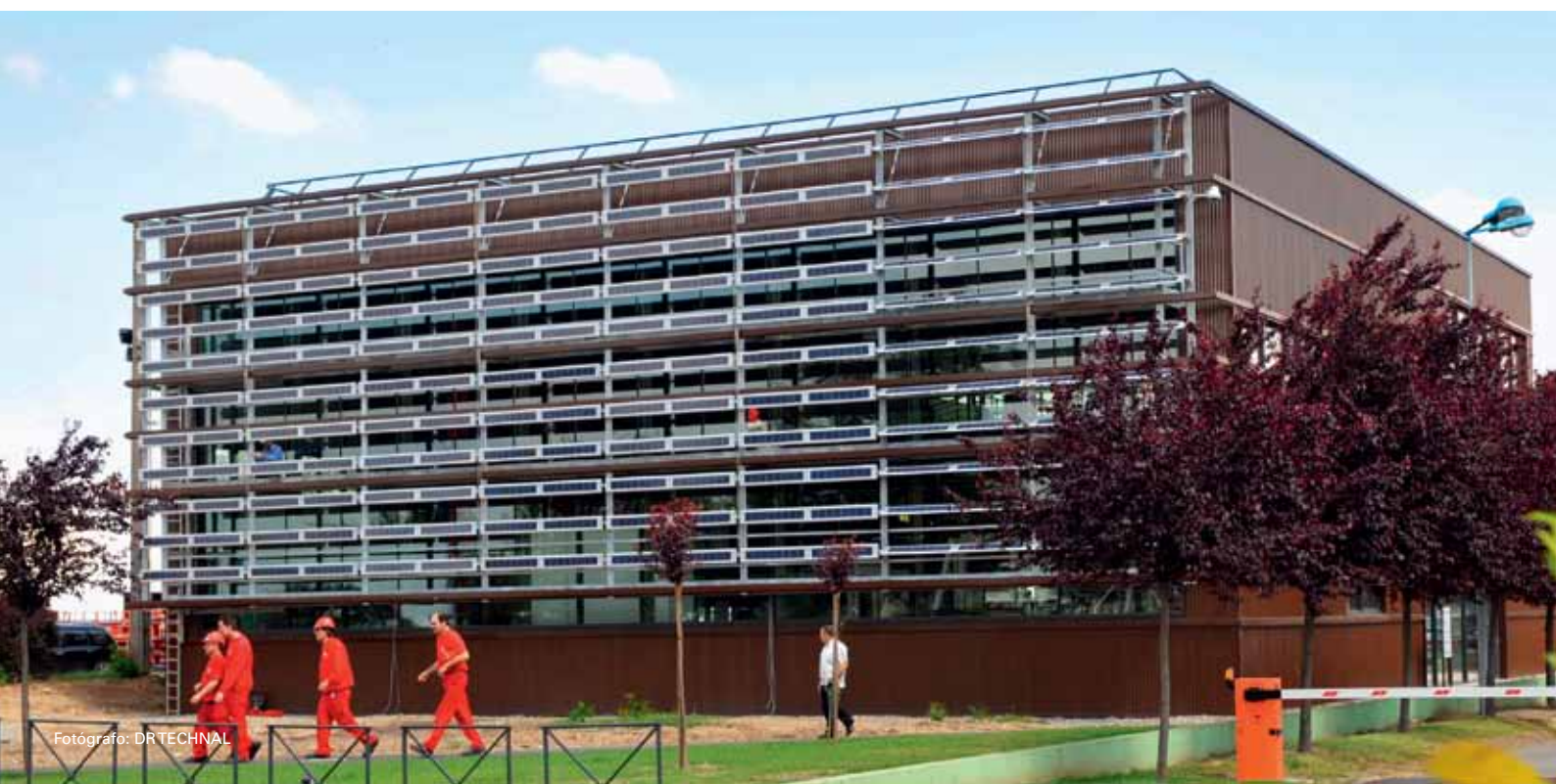
Fijación sobre estructura autoportante independiente de la fachada
