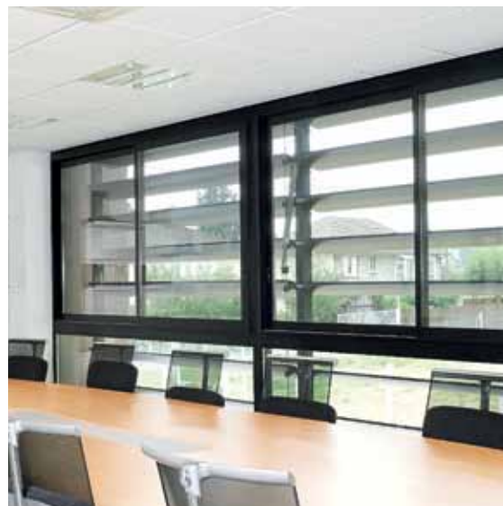
Lamas de 300 mm motorizadas - Inclinación 15°
